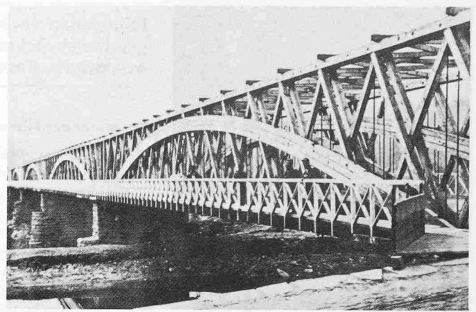
Bild 5 (rechts). Bogenverstärkter Howescher Träger über den Potomac bei Washington D.C. (aus [1] entnommen)
