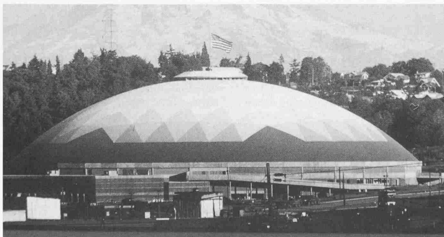
Bild 1. Holznetzschale in Tacoma, Seattle. Überdachung eines Sportstadions
