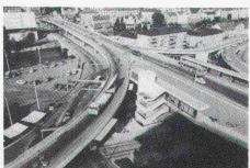
Autobahn N9. Brücken über die Paudèze 1971-74 @ Brücke mit 3 Feldern von 104 m und 2 Randfeldern von 55 m Spannweite.
