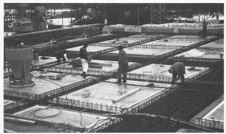
Bild 16. Die Kassettendecke des Importeuremarktes während dem Bauvorgang
