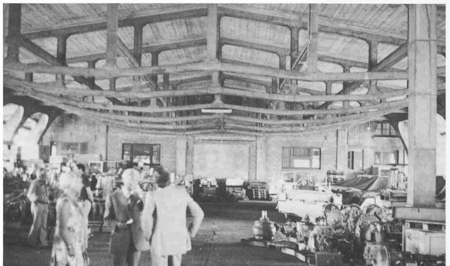
Innenansicht mit den Beton-Fachwerkträgern
