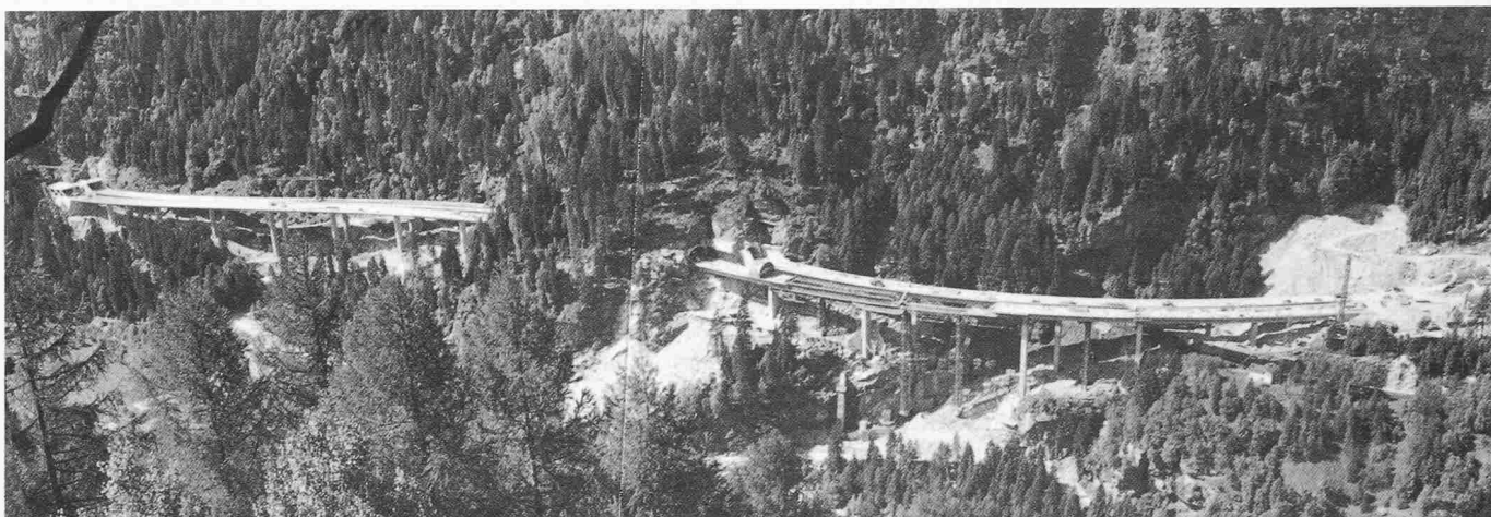
Baustellen Traseggio (links) und Monte (rechts), Bauzustand Juni 1982; Aufnahme: B. Meyer, Zürich
