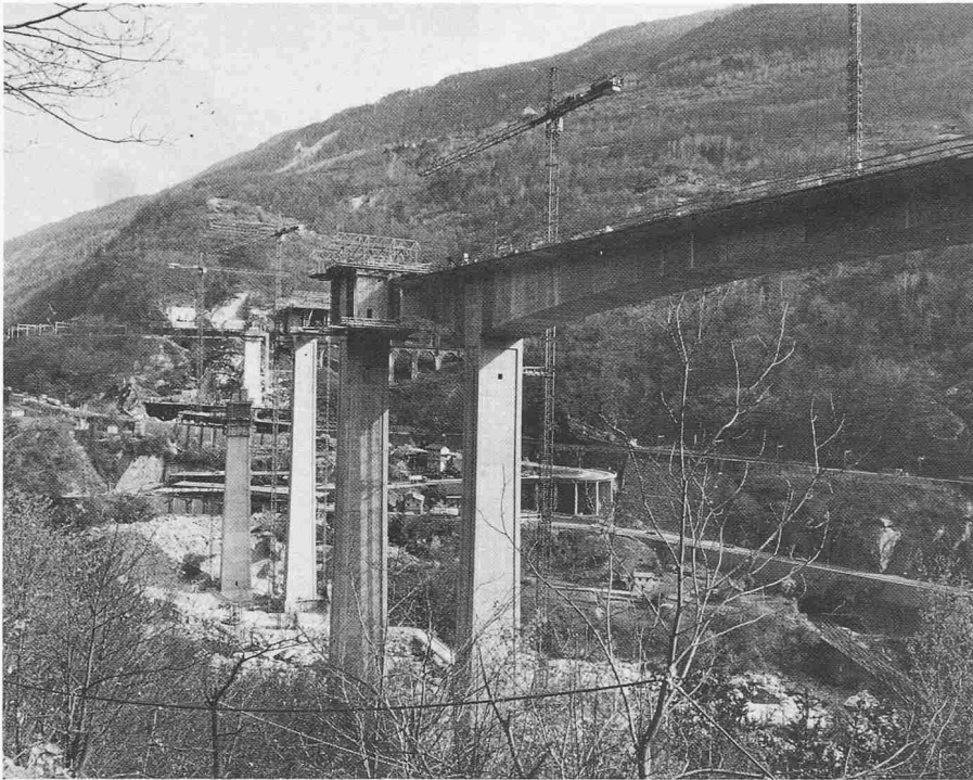
Baustelle Viadotto della Biaschina
