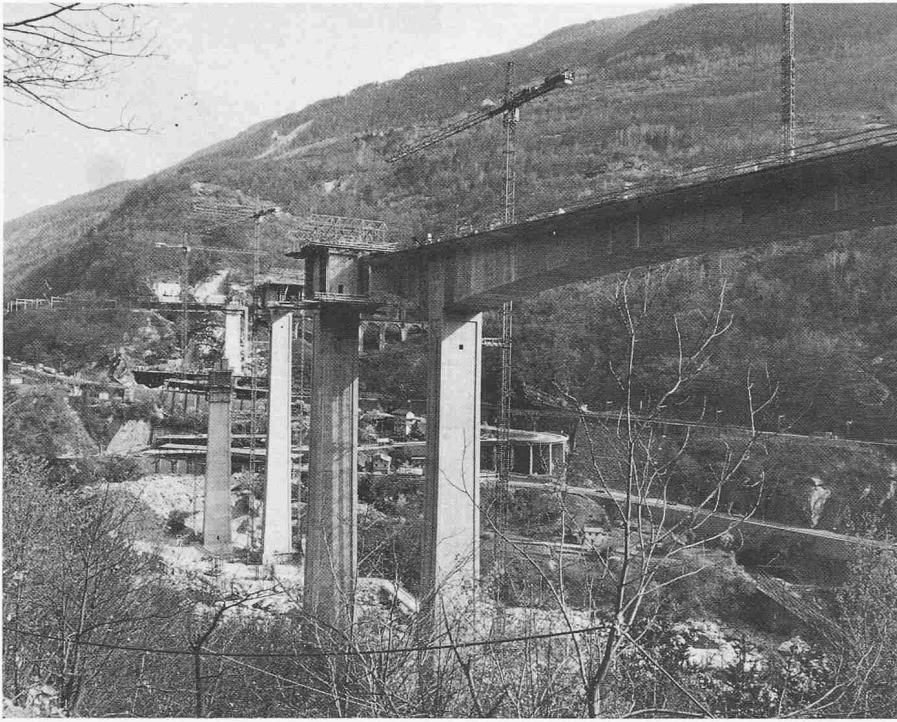
Baustelle Viadotto della Biaschina
