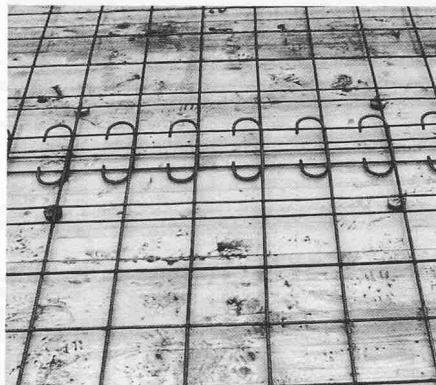
Bild 12b. Gut sicht- und kontrollierbarer Schlaufenstoss (200 mm)
