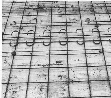
Bild 12b. Gut sicht- und kontrollierbarer Schlaufenstoss (200 mm)
