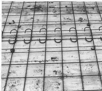
Bild 12b. Gut sicht- und kontrollierbarer Schlaufenstoss (200 mm)
