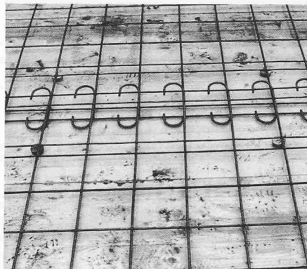
Bild 12b. Gut sicht- und kontrollierbarer Schlaufenstoss (200 mm)
