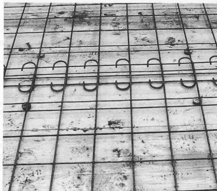
Bild 12b. Gut sicht- und kontrollierbarer Schlaufenstoss (200 mm)
