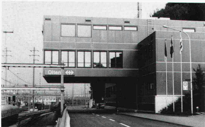
Neues Stellwerk Bahnhof SBB, Olten, Fahrbahnisoliation
