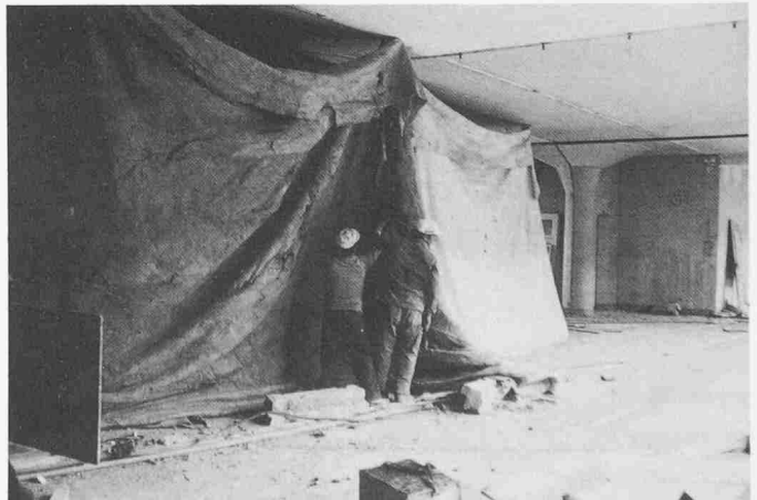
Bild 4. Liftschacht im nördlichen Flügel. Vor der Sprengung: Anbringen der dreifachen Vorhänge aus schwerer Vliesmatte
