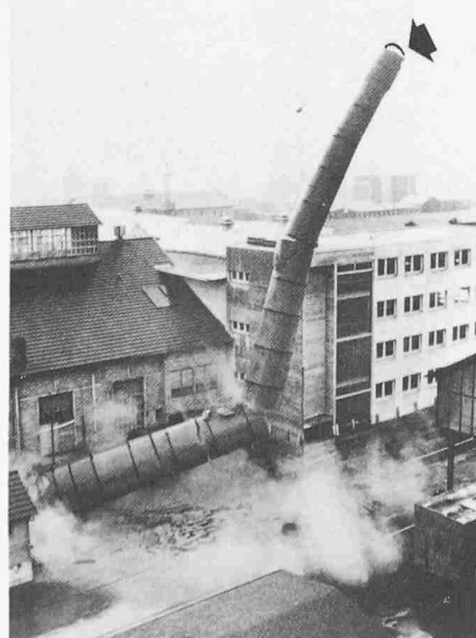
Bild 6. Wegschleudern des Gussrings
