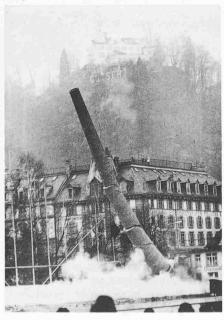
Bild 2. Beispiel für Knickstelle (Waggon-Fabrik Schlieren)
