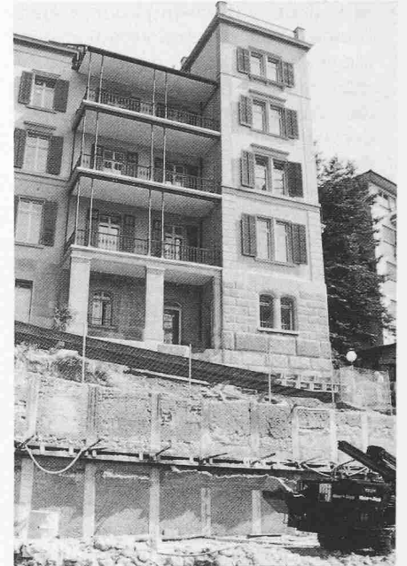
Bild 10. Ansicht der Rühlwand während der ersten Aushubetappe
