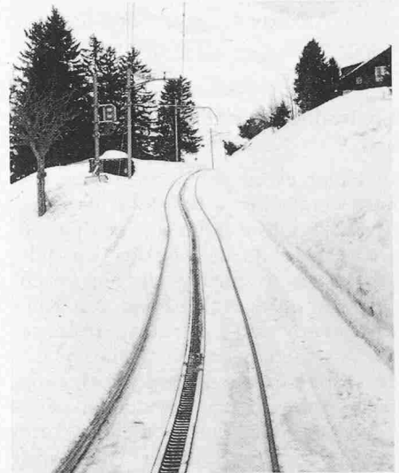
Bild 6. Verschiebung des Bahngelises als Folge der Hangrutschung vor der Sanierung
