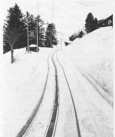
Bild 6. Verschiebung des Bahngelaises als Folge der Hangrutschung vor der Sanierung
