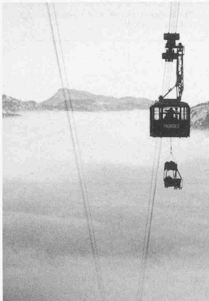
Bild 11. Antransport des Spannmaterials mit der Seilbahnkabine
