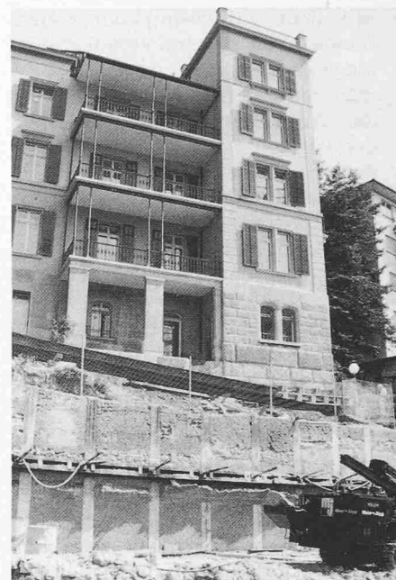
Bild 10. Ansicht der Rühlwand während der ersten Aushubetappe
