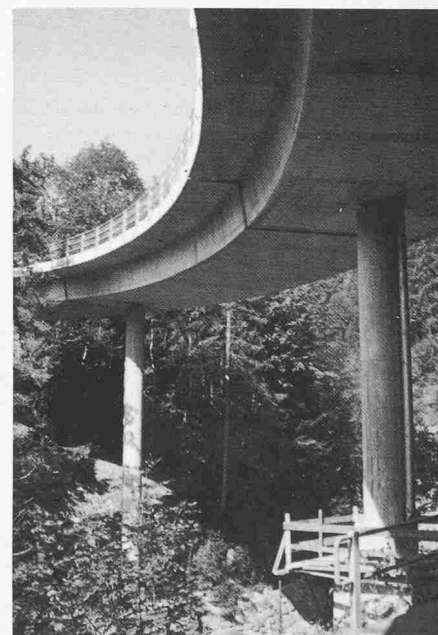
Bild 6. Brückenunterseite mit Pfeilern und Gerüst zur Lagerregulierung
