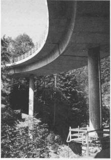
Bild 6. Brückenuntersicht mit Pfeilern und Gerüst zur Lagerregulierung
