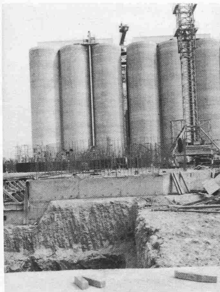
Bild 6. Mühle Quasseem, Saudi-Arabien. Getreidesilos der ersten Etappe und Maschinenhausbaugrube der zweiten Etappe (Photo Baustelle)
