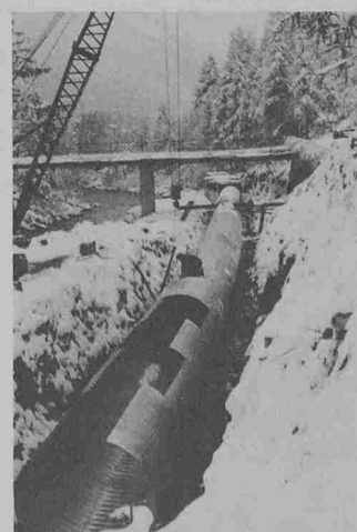
Verlegen des Armco-Durchlaufkanales
