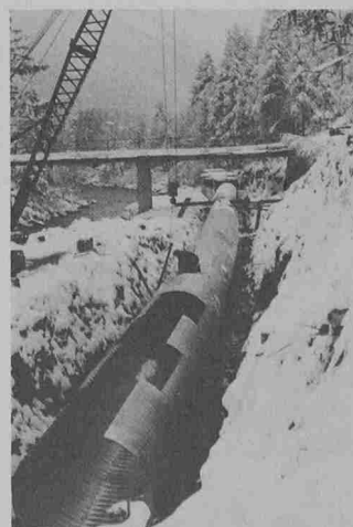
Verlegen des Armco-Durchlaufkanales
