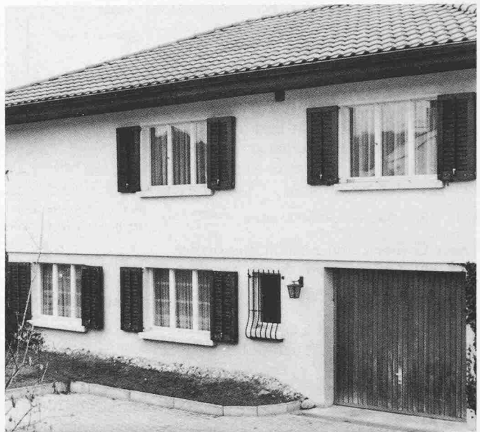
Bild 4. Photographische Aufnahme einer Fassade
