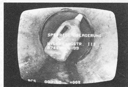
Bild 7. Kanalfernsehaufnahmen zur Beurteilung des Bau- und Betriebszustandes
