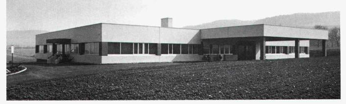
Diese Fabrikationshalle wurde nach den Vorstellungen und Wünschen des Bauherrn mit vorfabrizierten Betonelementen geplant. Wir haben sie in 14 Tagen montiert. Betonhallen sind solide und sichern der Bauherrschaft eine hohe Wertbeständigkeit.
