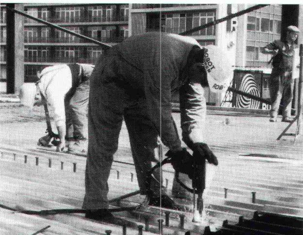
Die Schweißarbeiten werden rationell und wirtschaftlich mit speziellen NELSON-Bolzenschweißgeräten ausgeführt. Sie können vom Anwender selbst oder vom
