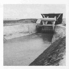
Bild 9. Hydraulische Schütze eines Bewässerungskanals (Marokko). Die Position der Schütze ist eine Funktion des Unterwasserspiegels
