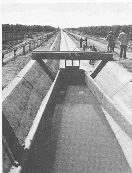
Bild 2. Prismaförmiger Bewässerungskanal mit einem «Entenschnabel»-Überfall. Solche Überfälle repräsentieren auf einfache Weise das Prinzip der Regulierung des Kanals nach dem Oberwasserspiegel
