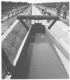
Bild 2. Prismatischer Bewässerungskanal mit einem «Entenschnabel»-Überfall. Solche Überfälle repräsentieren auf einfache Weise das Prinzip der Regulierung des Kanals nach dem Oberwasserspie-
