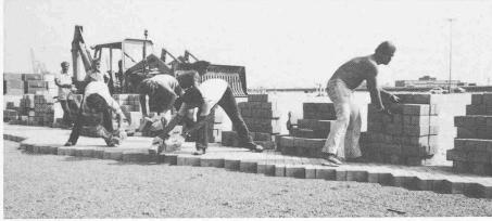
Betonpflastersteine (20/10/12 cm) im trockenen Splittbett zur Befestigung schwerbelasteter Hafenflächen (Container-Terminal) verlegt
