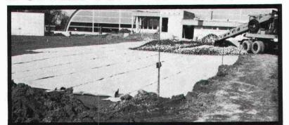
Trennschicht zwischen Untergrund und Strassenoberbau, als Filter bei Drainagen, Dammschüttungen und Böschungen.
