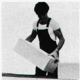
1 Gemauert als monolithisches, homogenes Fassadenmauerwerk mit dem k-Wert 0,24 W/m2K bei 35 cm Wandstärke, Qualität GL und 5 Gew.-%= Feuchtigkeit.
