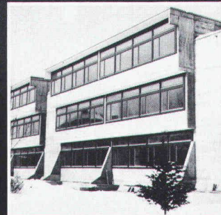
Erdbebensichere Lagerung eines Schulhauses in Jugoslawien (Einweihung 1969).
