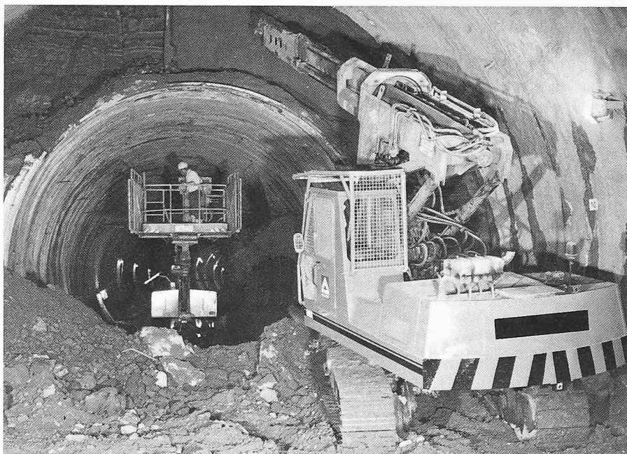
Bild 3. Während der Vortriebsarbeiten und der Sicherung mit Spritzbeton nach der NATM
