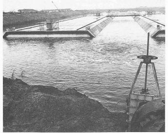
Bild 4. Fluten eines Trockendocks und Ausschwimmen der Tunnelteilstücke zur Tunnelbaustelle und dort Absenken auf die vorbereitete Kanal- oder Flusssohle (Coen-Tunnel, Amsterdam)
