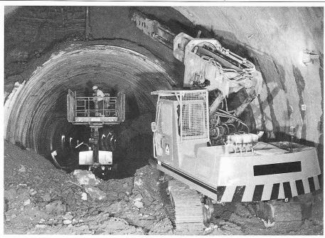
Während der Vortriebsarbeiten und der Sicherung mit Spritzbeton nach der NATM
