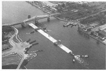
Einschwimmen eines 268 m langen Tunnelstücks (50 000 t) für den Hemspoor-Tunnel in den Niederlanden
