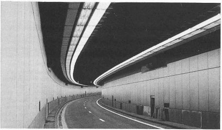
Bild 7. Unterwassertunnel in den Niederlanden mit Wärmedämm-Spritzputz an der Tunneldecke zum
