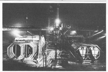
Bild 3. Herstellen von Tunnelteilstücken im Trockendock (Metro, Rotterdam)
