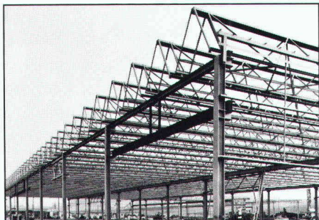
Metallstruktur eines Fabrikgebäudes mit Mini-Sheddach
