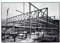
Stahlkonstruktion einer Lager-bzw. Einstellhalle für Material und Fahrzeuge
