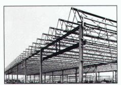
Metallstruktur eines Fabrikgebäudes mit Mini-Sheddach
