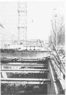
Amt für Brücken- und Tiefbau der Stadt Essen ausführte, hat die ARGE vier Fahrspuren zunächst auf der Ostseite, später auf dem Deckel der fertigen Weströhre während der ganzen Bauzeit offengehalten.
