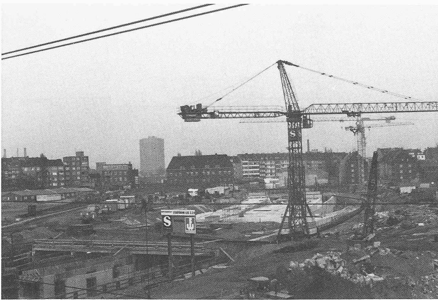
Bild 4. Baugrube der Zufahrten der S-Bahn zum Bahnhof
