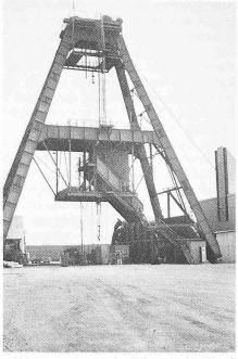
Bild 8. Der Förderturm des Gefrierschachtes Voerde
