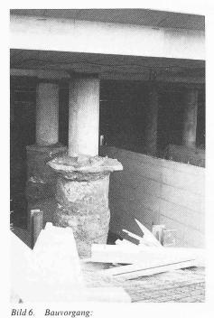
1) Erstellen der Bohrpfähle. 2) Bau der Brücken darüber. 3) Aushub unter den Brücken für die Einführung der S-Bahnen in den Bahnhof
