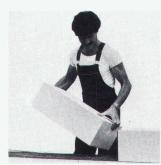
1 Gemauert als monolithische Fassade mit dem k-Wert 0,24 W/m2K bei 35 cm Wandstärke, Qualität GL und 5 Gew.-% Feuchtigkeit.
