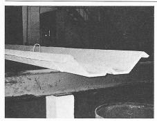
Bild 13. Selbsttragendes Dachelement aus Ferrozement (Bangkok, Asien Institute of Technology, Photo: H.D. Sulzer)
