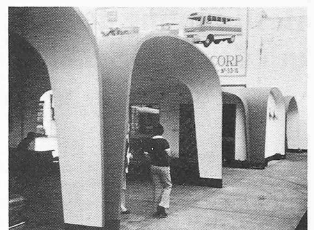
Bild 15. Prototyp Ferrozement-Haus in Manila (Photo: H.D. Sulzer)
