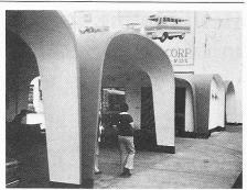
Prototyp Ferrozement-Haus in Manila (Photo: H.D. Sulzer)
