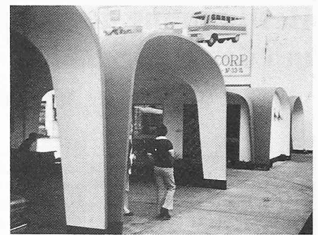
Bild 15. Prototyp Ferrozement-Haus in Manila (Photo: H.D. Sulzer)
