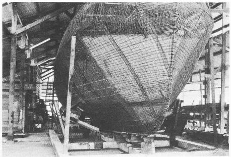
währten. Nach dem Zweiten Weltkrieg wurde vermehrt mit Ferrozement experimentiert, so etwa durch den italienischen Architekten und Konstrukteur Luigi Nervi (1891–1979), der feststellte, dass manche Eigenschaften des neuen Kompositmaterials sich von denen des konventionellen Stahlbetons stark unterscheiden. Er nannte es «Ferrocimento» und baute damit verschiedene grossflächige Dünnschalen über Stadien, Hallen usw.
