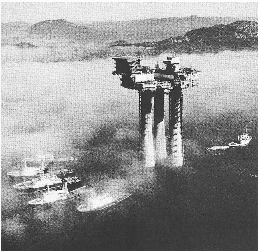
Bild 6. Die fertige Bohrplattform wird über 400 km Distanz zum Ölfeld geschleppt
