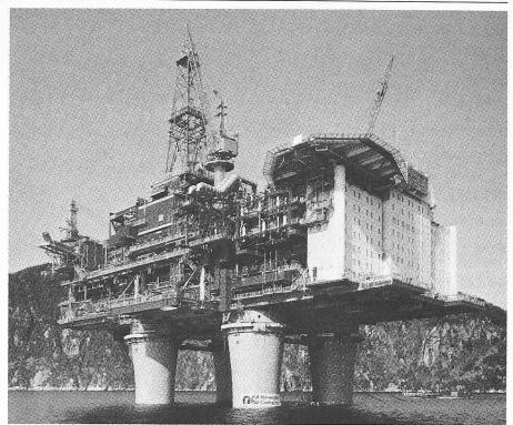
Bild 4. Aufbaute der Condeep-Plattform
