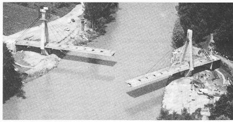
Bild 2. Passerelle de Meylan während des Drehvorgangs
