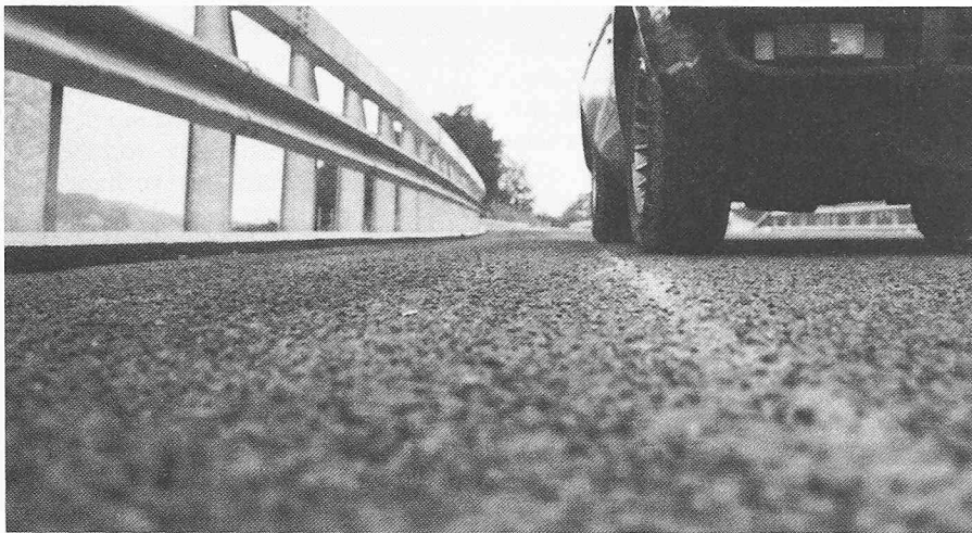
Bild 6. Griffiger GA-Belag auf Brücke, nach 5 Jahren Beanspruchung
