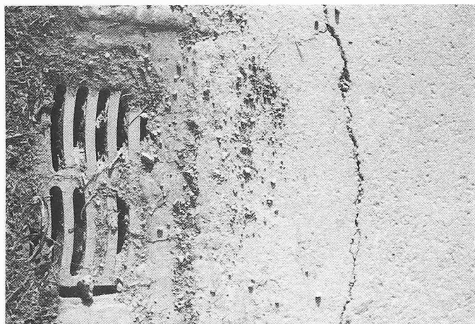
Bild E1. Sichtbar: gerissener Walzasphalt
