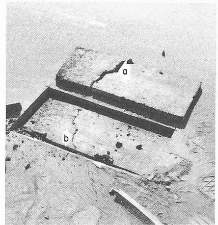
Bild A5. Die Verschlussschicht hat auf der Ausgleichsschicht geschoben (a) und ist gerissen. Unter dem Riss (b) steht ein «Schmutzkamm» auf der Ausgleichsschicht; sie liess sich nur brockenweise entfernen. Bei näherer Prüfung zeigten sich Ablösungen der Abdichtung in der Oberflächenzone des Betons
