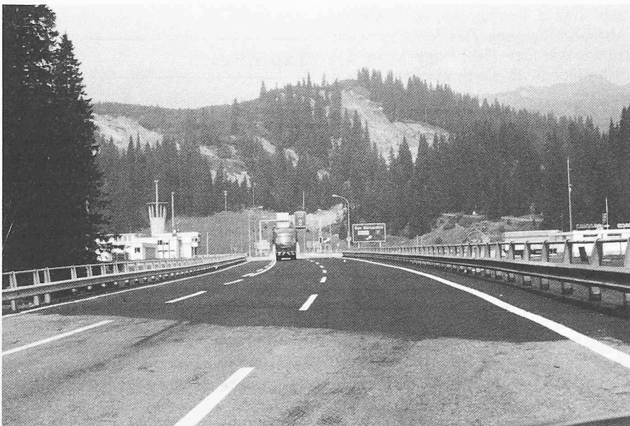
Bild 1. Sanierte Brücke in intakter Strasse
