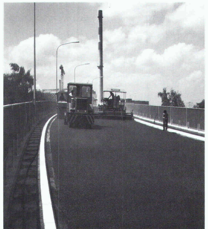
Einbau der Schutzausgleichs- und Verschleiss-Schichten
