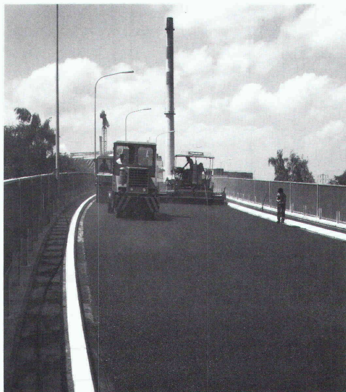
Einbau der Schutzausgleichs- und Verschleiss-Schichten
