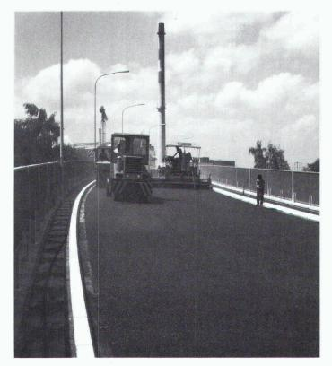
Einbau der Schutzausgleichs- und Verschleiss-Schichten
