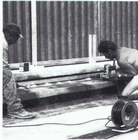
Fixieren der Isolation mit Chromstahlschienen
