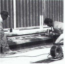
Fixieren der Isolation mit Chromstahlschienen
