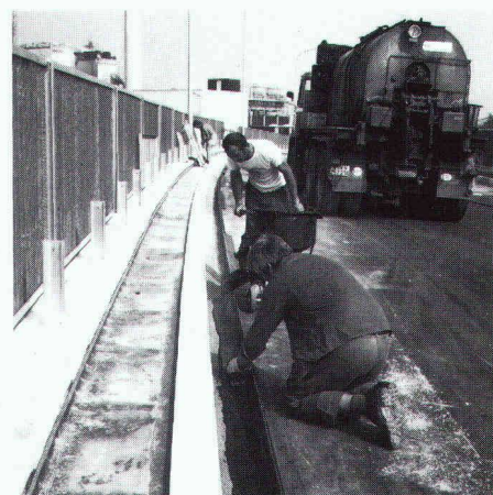
Einbau der Gussasphalt-Wasserrinne
