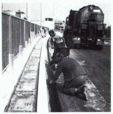
Einbau der Gussasphalt-Wasserrinne
