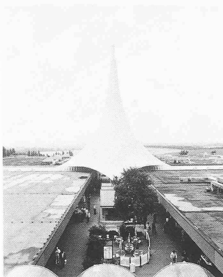
Eine 40 m hohe textile Überdachung aus Trevira hochfest bildet das neue Wahrzeichen des Einkaufszentrums Ruhrpark bei Bochum
