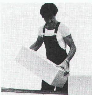
1 Gemauert als monolithisches, homogenes Fassadenmauerwerk mit dem  $k$ -Wert  $0,24 \text{ W/m}^2\text{K}$  bei  $35 \text{ cm}$  Wandstärke, Qualität GL und 5 Gew.-% = Feuchtigkeit.
