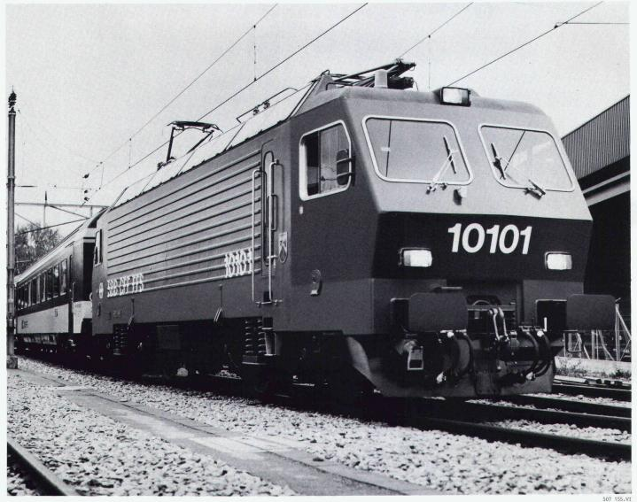
Vierachsige Stromrichter-Streckenlokomotive Re 4/4 IV Nr. 10101-10104 der Schweizerischen Bundesbahnen Universell eingesetzt auf Mittellandstrecken sowie im Gebirge, an der Spitze eines Intercity-Zuges mit Einheitspersonenwagen Typ EW IV (15 kV/163 Hz, 5072 kW einstündig bei 85 km/h und 210 kN Zugkraft, maximal 160 km/h, Anfahrzugkraft 300 kN, Masse 80 t)
