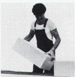
herr in Bezug auf Wirtschaftlichkeit, Wärmedämmung, Dampfdiffusion und Raumklima. Ein massives SIPOREXplus-Mauerwerk der Qualität GL weist bei einer Wandstärke von 35 cm und einem Feuchtigkeitsgehalt von 5 Gew.-% einen k-Wert von 0.24 W/m2K auf Die grossformatigen Steine gewährleisten einen raschen Baufortschritt und niedrige Erstellungskosten. SIPOREXplus, das Schweizer Qualitätsprodukt, wird in Estavaver-le-Lac hergestellt.
