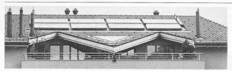
Bild 22. Spezielle Dachgestaltung mit Sonnenkollektoren
