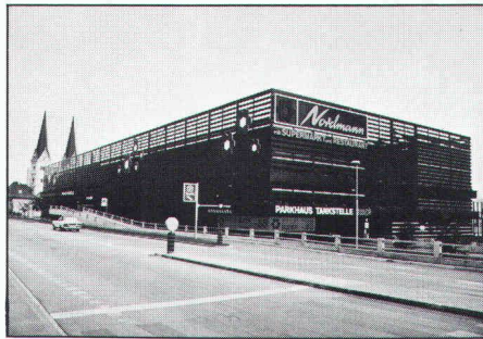
Traggerippe eines Handelszentrums mit Parkebene im Untergeschoss
