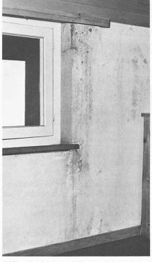
Feuchtigkeitsschäden im Gebäudeinnern, verursacht durch Rückschwellwasser, das bei Undichtigkeiten im Unterdach eindringen konnte
