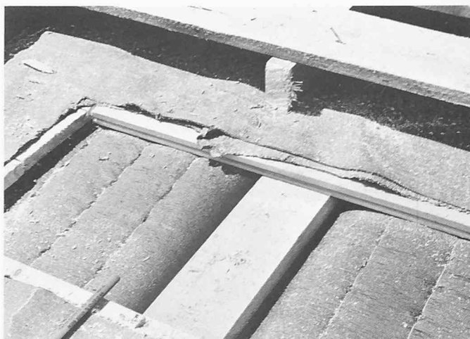
Bild 3. Probeöffnung auf dem Dache. Steinplatten entfernt, Unterdach aufgeschnitten, Sparren und Wärmedämmung sichtbar. Konterlatte nicht über dem Sparren liegend, Wärmedämmung mit Holzschalung in direktem Kontakt, kein belüfteter Hohlraum zwischen Wärmedämmung und Holzschalung
