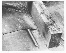
Bild 5. Probeöffnung auf dem Dache. Steinplatten entfernt, Unterdach sichtbar. Bitumendichtungsbahn mit offener Nahtstelle, Zimmermannsbleistift lässt sich durchstecken
