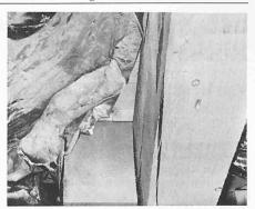
Probeöffnung im Gebäudeinnern. Deckenverkleidung entfernt, Wärmedämmung und Sparren sichtbar. Wärmedämmung nicht dicht an Sparren angeschlossen, Holzschalung des Unterdaches vom Gehäudeinnern her sichtbar
