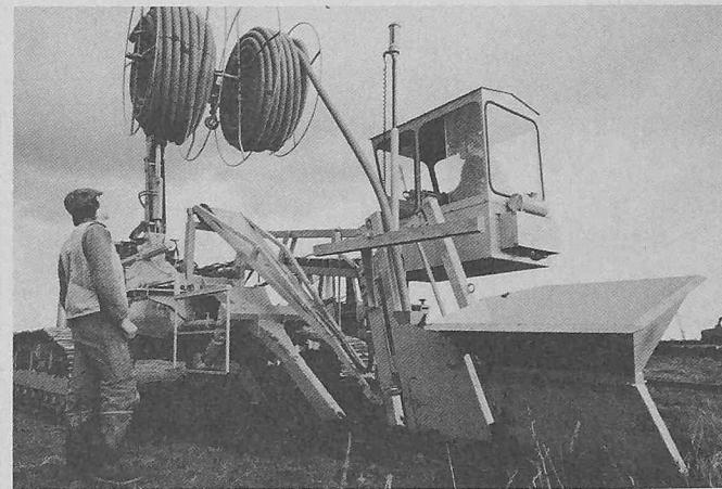
ungsgeräte, zu denen u. a. Maschinen mit einem Pflügmechanismus zählen. Diese verlegen Rohre und Kabel in einem Arbeitsgang, ohne dass zuerst Gräben ausgehoben oder nach der Verlegung wieder aufgefüllt werden müssen.
