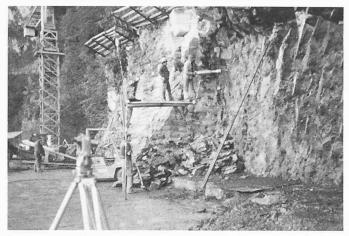
Bild 6. Ausbruch des Widerlagerriegels
