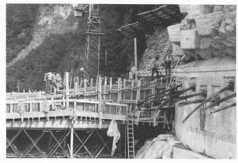
Bild 7. Felssicherungsanker (VU = 60 t). Felsanker im Widerlager. Betonieretappe Galeriedach
