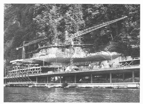
Bild 8. Lehrgerüst und auskragende Decke (Los 1)
