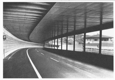
Bild 5. Lärmschutzgalerie (ausgeführt). Innenansicht
