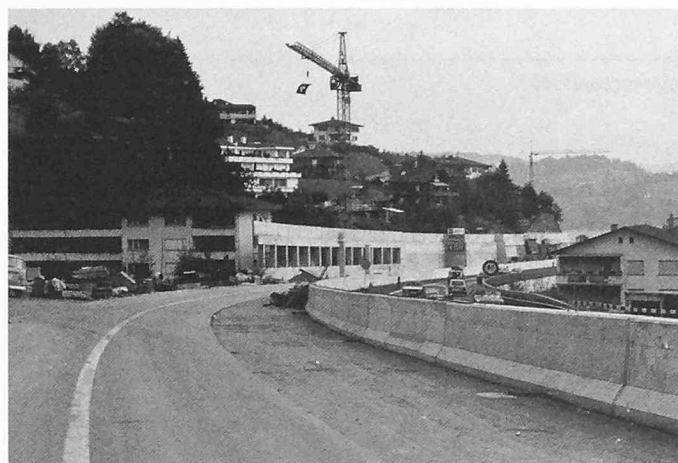
Bild 7. August 1981: Bau der Galerierückwand. Verkehrsführung: Gegenverkehr auf der Seeseite
