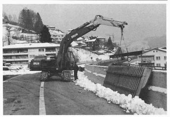
Bild 6. Januar 1981; Bau der New-Jersey-Mauer Verkehrsführung: Gegenverkehr auf der Seeseite
