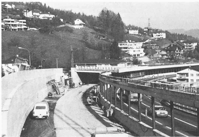
Bild 8. Nov. 1981: Versetzen der Betonrippenplatten auf Rückwand und Längsträger über der Mittelmauer. Verkehrsführung: Gegenverkehr auf der Seeseite
