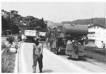
Bild 5. August 1980: Fräsarbeiten auf den seeseitigen Fahrspuren. Verkehrsführung: Gegenverkehr auf der Bergseite
