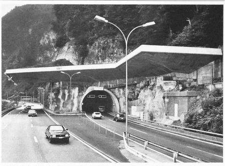
Bild 6. Steinschlagschutzbauten am Lopper (Los 1) über dem Westportal des bergseitigen Achereggtunnels
