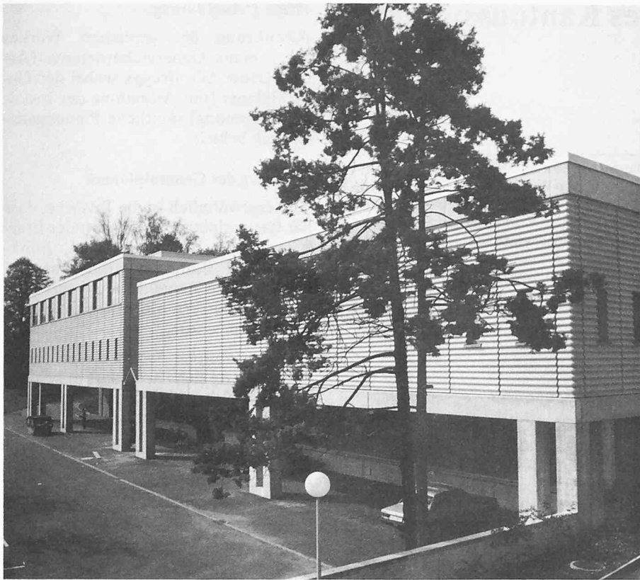
Versorgungsbetriebe. Ostfassade mit Anlieferung
