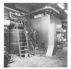
Heizkessel mit Kombibrenner Oel-Gas. Links: Velox-Kessel
