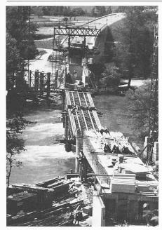
Bild 3. Bauzustand der Aarebrücke Ruppoldingen der SBB im Jahr 1978 mit allen 3 Bauphasen
