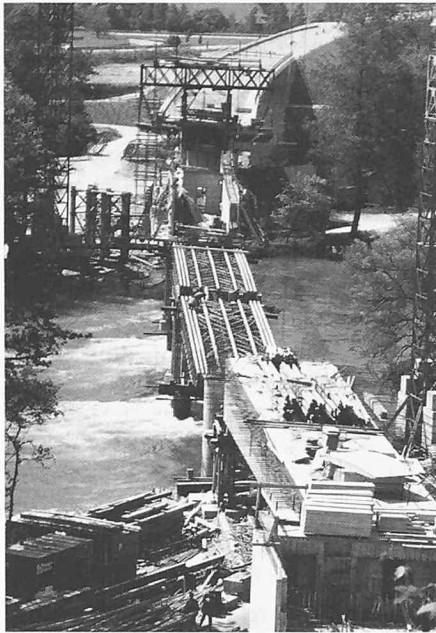
Bild 3. Bauzustand der Aarebrücke Ruppoldingen der SBB im Jahr 1978 mit allen 3 Bauphasen (nach [1])
