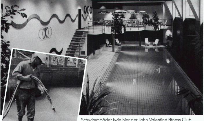
**RENESCO Abdichtungstechnik** Sowohl die Nahtstellen bei Betonierfugen als auch Wand- und Bodenflächen werden sicher und dauerwirksam mit zementgebundenen
