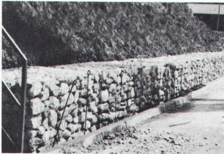
Beispiel einer Böschungverbauung
