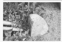
Die Hauptkabel laufen direkt in den Boden hinein. ohne von einem Steinsockel abgelenkt zu werden. Sie sind einzig durch Blechhülsen vor Rost geschützt, die mit Fett ausgepresst sind
