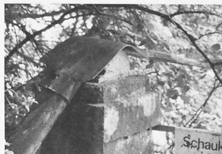
Detail eines Pylonsattels mit gusseisernem Zylinder
