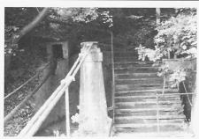
An beiden Brückenenden (hier die Damsauseite) laufen die Hauptkabel über gusseiserne Zylinder. die auf den Pylonen angebracht sind
