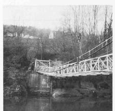
besten Korrosionsschutzes auf Montage nur noch verschraubt wurden. Der neue Bohlenbelag aus imprägniertem Lärchenholz wurde auf die neuen Längsträger mit ebenfalls feuerverzinkten Schrauben befestigt. Durch diese konstruktiven Massnahmen sollte der unterhaltsarme Bestand des sanierten Hängesteges nun wieder auf mehrere Jahrzehnte gesichert sein.
