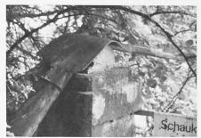
Detail eines Pylonsattels mit gusseisernem Zylinder
