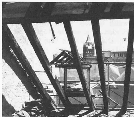
Auch bei den Dachstuhl wurde versucht, möglichst viel der vorhandenen Substanz zu retten
