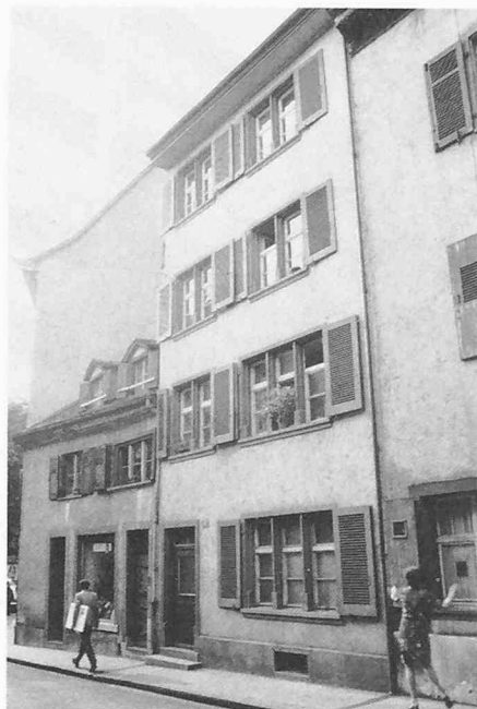
Rheingasse 65+67, Strassenfassade, vor der Sanierung
