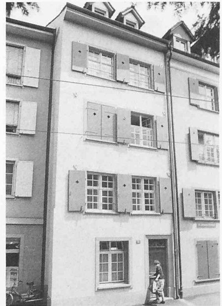
Strassenseite nach der Sanierung
