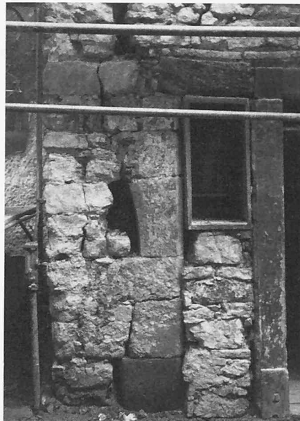
Sanierung des Eckverbandes, Detailansicht
