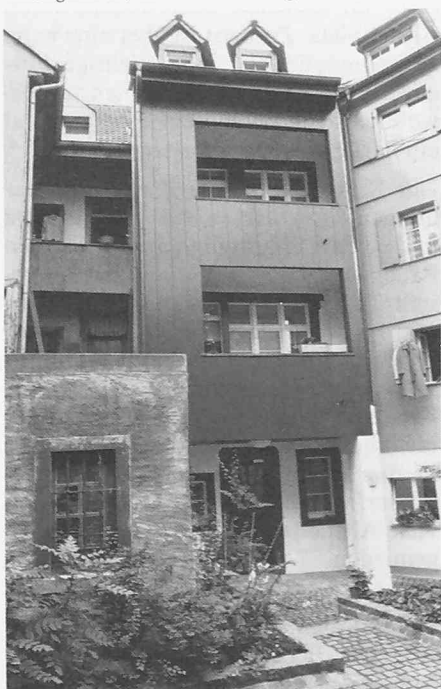
Rheingasse 69, nach der Sanierung
