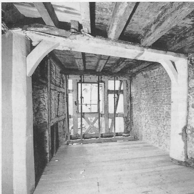
Freigelegte Tragkonstruktion im Haus Rheingasse 67
