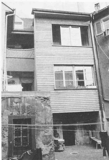
Rheingasse 69, Hoffassade, vor der Sanierung
